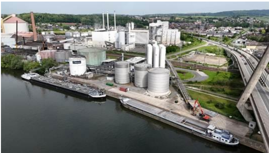
Chargement éthanol et déchargement blé fourrager chez BioWanze. (C)SPW-DGIT
