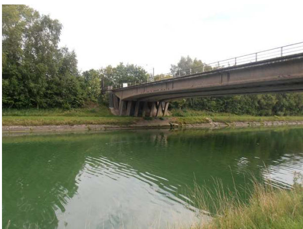
Vue du pont depuis le halage – © SPW Photo en meilleure résolution
